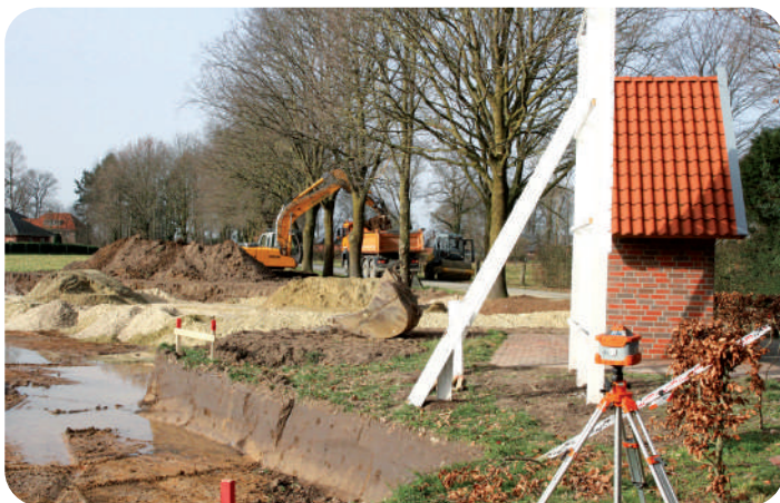
Baggerarbeiten für das Inklusionshaus
