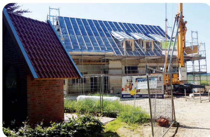
Die Bauarbeiten schreiten voran
