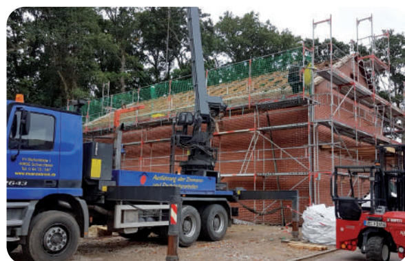
Das Kühlhaus erhält ein neues Pfannendach
