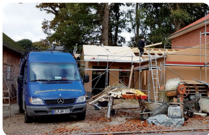
Herstellung des Daches
