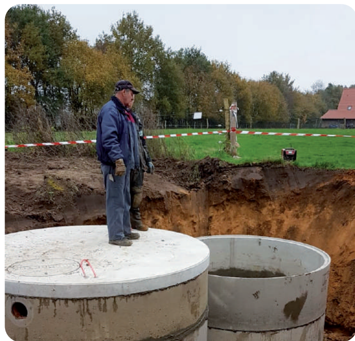
Einbau der Regenwasserbehälter
