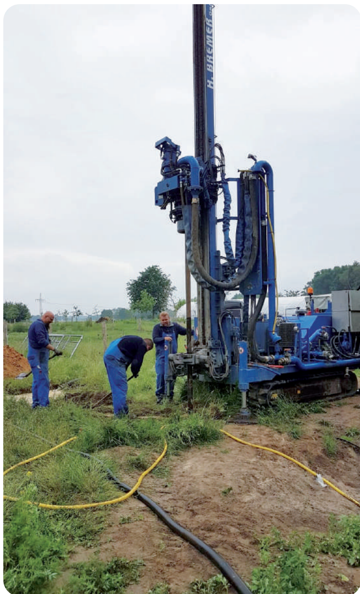
Erstellung des Bohrbrunnens
