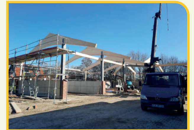
Svenja verfolgte den Neubau der Halle
