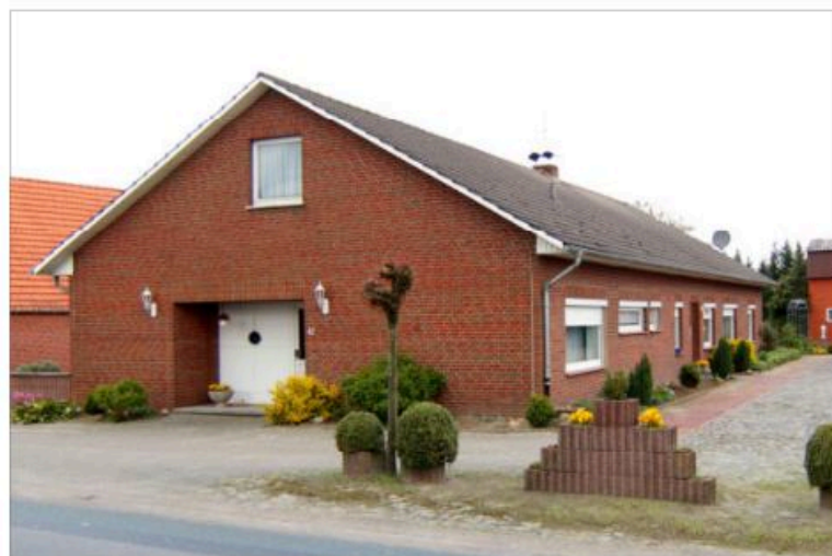
... wurde nach ca. 50 Jahren abgerissen, das Wohnhaus !!
