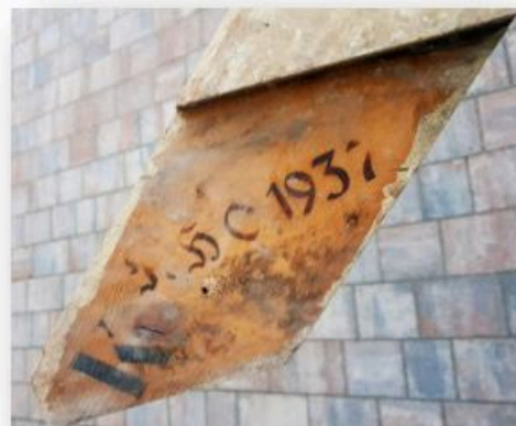
Der Holzbalken stammt aus dem alten Haus. Die Inschrift deutet wohl auf das Baujahr 1937 hin.
