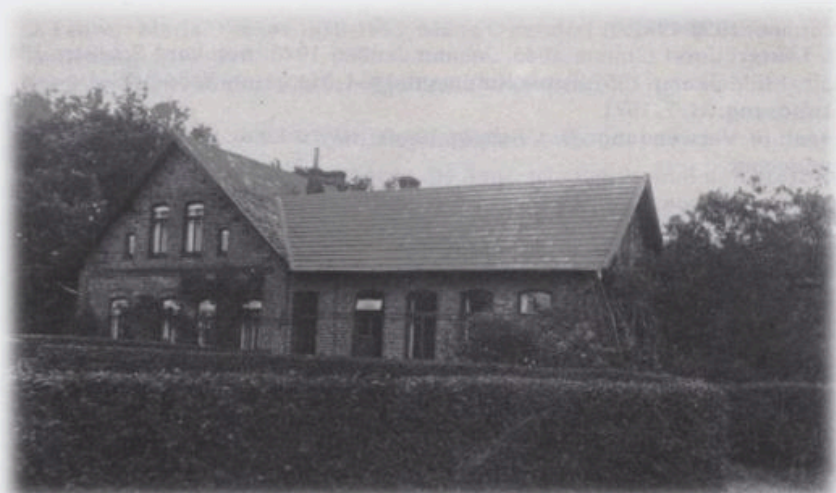
Die alte Schule aus westlicher Sicht. Der Klassenraum befand sich im rechten Bereich. Im linken Teil waren zuletzt 2 Wohnungen untergebracht. Es war die 3. Schule in Deindrup und wurde 1899 errichtet.
