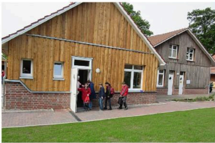
... der neue Eingang zum Sozialraum/Küche
